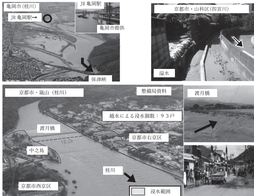
図7 2013年台風第18号の豪雨による京都市内河川の状況 (京都府 (2014) の資料より著者作成)
